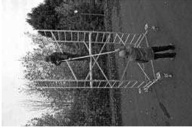
**Wskazówka: Do montażu i demontażu przewidziane są pomosty pomocnicze. Po zakończeniu montażu i demontażu należy je usunąć. Według normy DIN4420-1 deski muszą mieć szerokość nie mniejszą niż 24 cm a grubość przynajmniej 4,5 cm. Do zamocowania pomostu deski muszą być dłuższe od rusztowania o przynajmniej 20 cm z każdej strony.**
