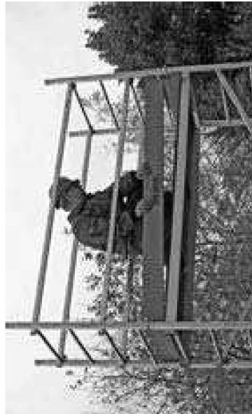
Na zdjęciu gotowe, zmontowane rusztowanie z pomostem na wysokości 4,3 m.
